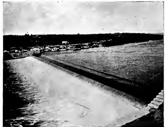
FIG. 10.—DAM AT SEWALL'S FALLS, N. H.
